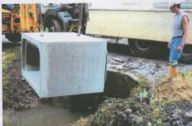
Ci-dessus, une phase délicate du chantier : la pose d'un des deux caissons permettant le passage des tuyaux au-dessus de l'Ancoutay.
