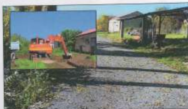
Décaisement, empierrement et goudron bi-couches afin de réaliser un accès à l'atelier municipal
