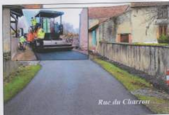
Décaisement, empierrement et goudron bi-couches afin de réaliser un accès à l'atelier municipal
